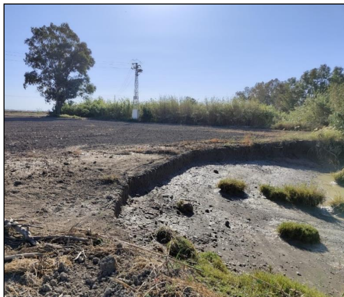
Ilustración 49. Imagen de la vegetación de ribera encontrada a la zona de la Corta de los Jerónimos. Se puede observar, la margen muy erosionada (incluso con un bocado) y la escasa vegetación que existe en donde está el bocado.
