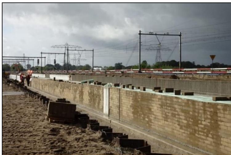
Ilustración 12. Ejemplo de una barrera acústica construida con sedimentos excavados en la construcción de un túnel de ferrocarril. Fuente: Geowall en Deltares, jornadas Sediment Management, 2021
